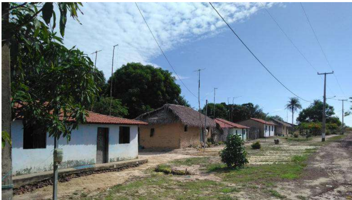
Figura 4 - Casas da comunidade Mamuna
